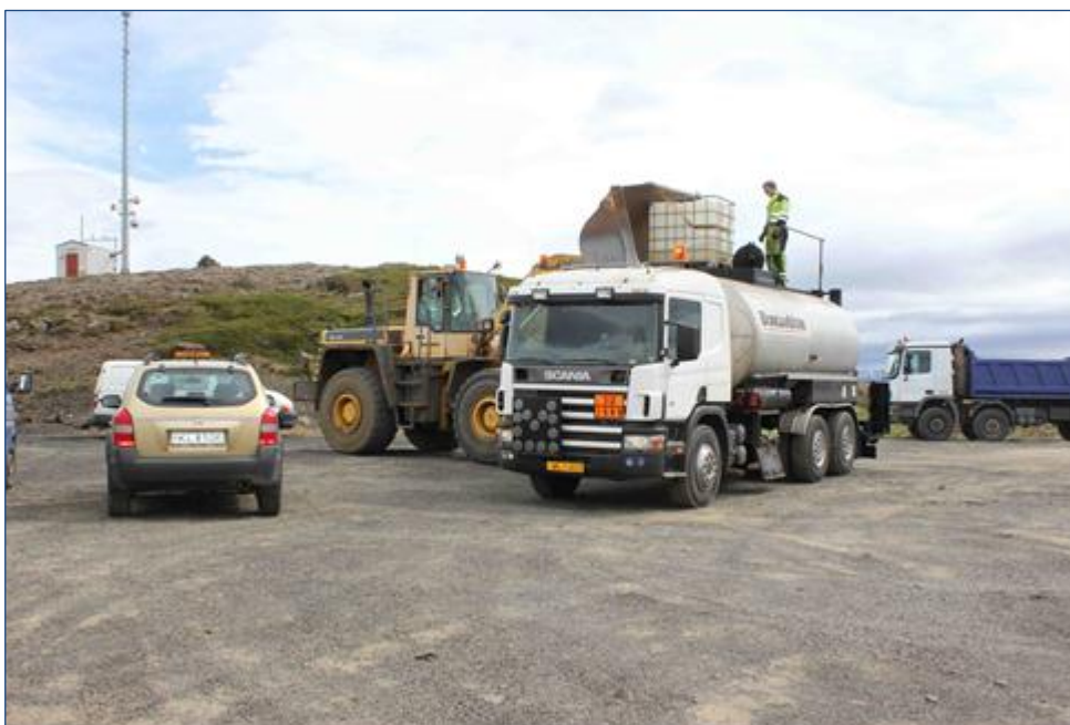
Mynd 6 Undirbúningur fyrir blöndun sæolú í dreifitank
