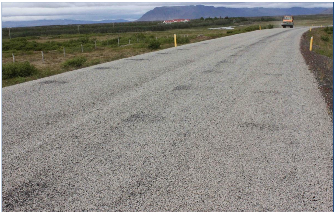
Mynd 9 Bindiefnisblettir, steinefnadreifari dregur með sér bindiefni eftir stopp malarbíla
